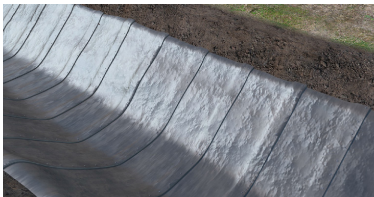
Rellene la zanja de anclaje
