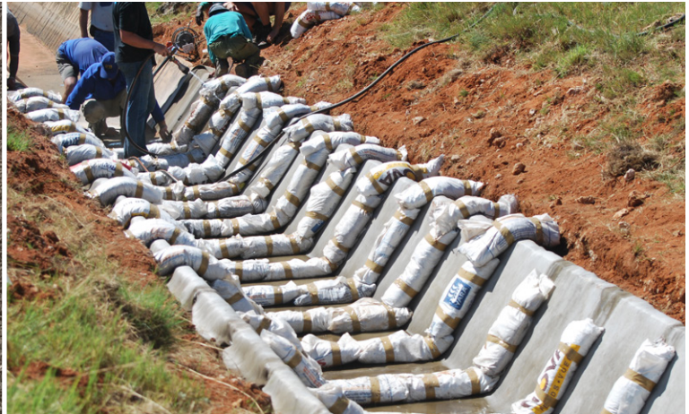
Se pueden utilizar bolsas de arena para comprimir las juntas durante el fraguado
