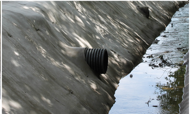
Paso retrospectivo de tuberías
