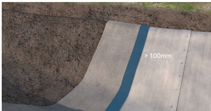
Solape las capas de CC 100 mm como mínimo
