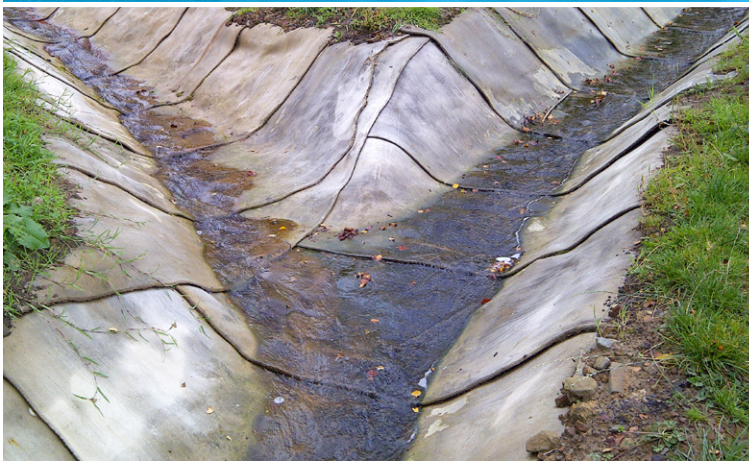
El CC se puede manipular fácilmente para formar empalmes y terminales de zanjás
