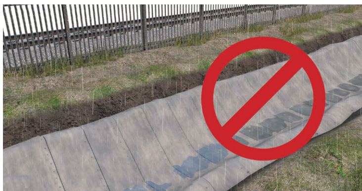
Garantice una hidratación adecuada, no dependa de las precipitaciones
