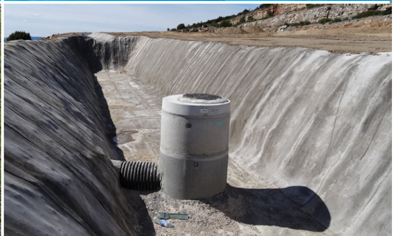
CC puede instalarse alrededor de infraestructura existente
