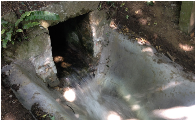
Se puede utilizar un mortero adecuado para unir y sellar el CC a una infraestructura existente
