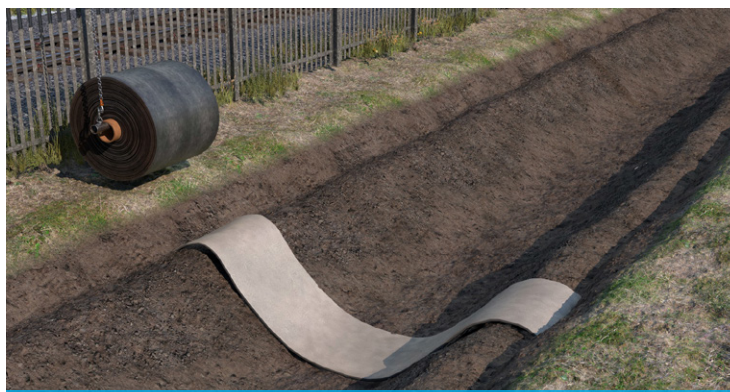
CC metido en zanja de anclaje antes del corte
