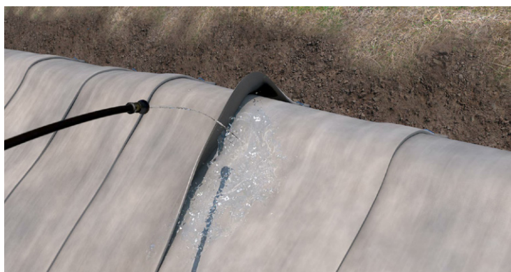
Hidrate debajo de las juntas antes de fijar
