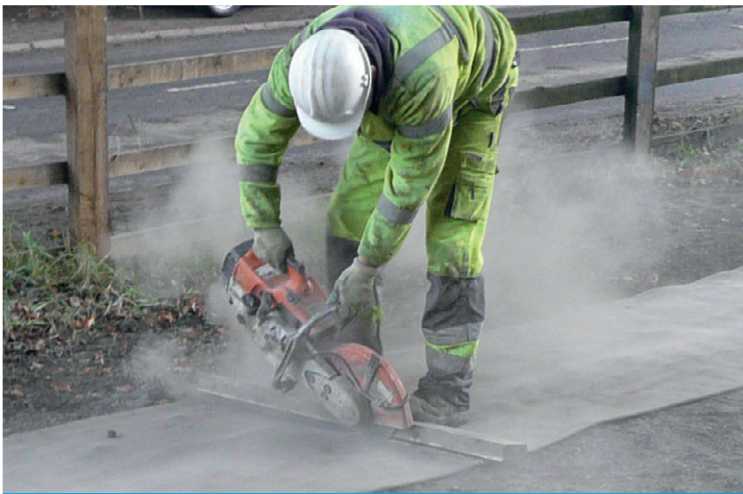
Corte de CC con cortadora de disco eléctrica
