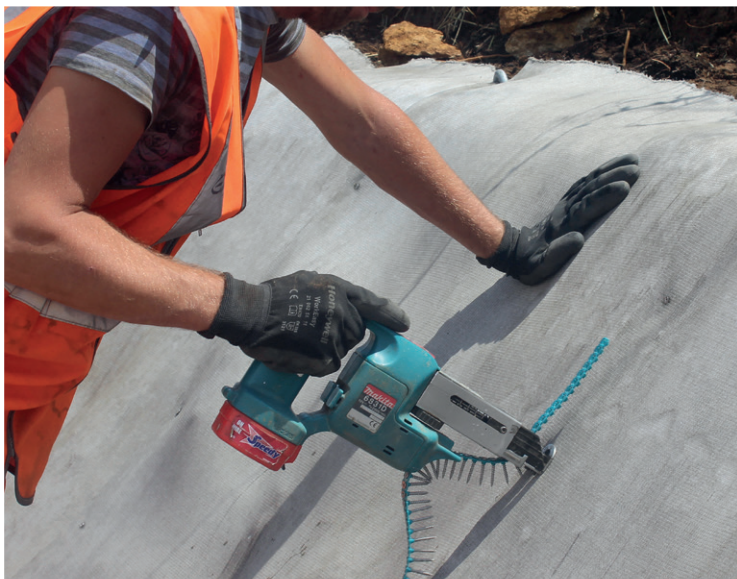
Junta de CC fijada con atornillador automático
