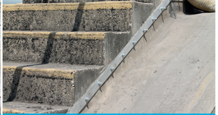
Fijación con barra de acero galvanizado perforada
