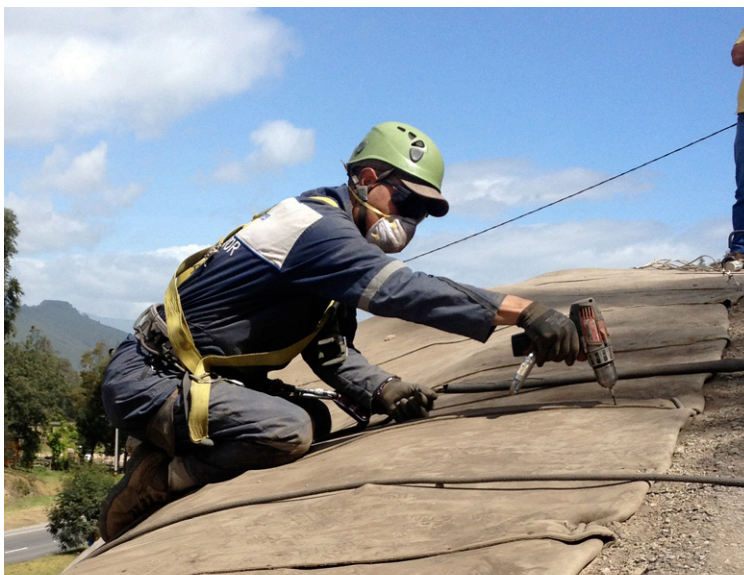
Unión de capas de CC adyacentes con tornillos de acero inoxidable
