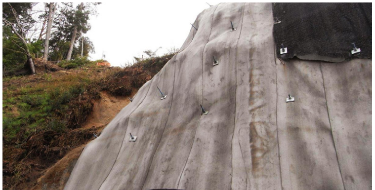
Proyecto de estabilización y protección de talud con CC, Karapiro Gully, Nueva Zelanda
