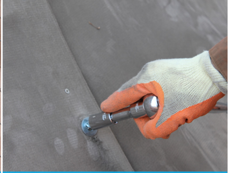
CC fijado a talud con perno para roca
