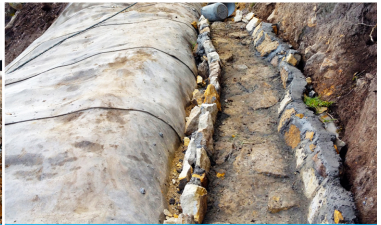
Zanja de anclaje de hormigón construida sobre CC en la cresta del talud
