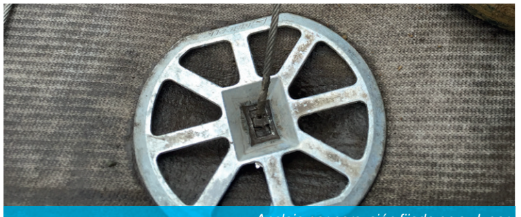
Anclaje por percusión fijado en su lugar
