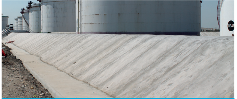
CC capturado con un cordón de hormigón vertido
