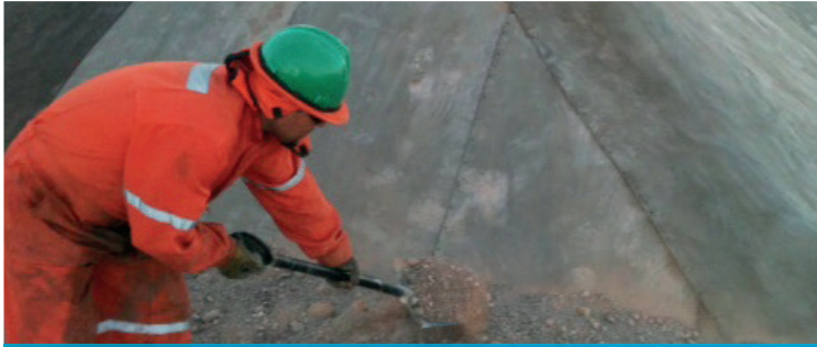
CC con zanja de anclaje
