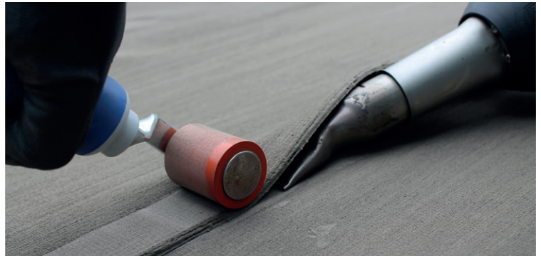
Pistola manual de aire caliente con boquilla ranurada en uso
