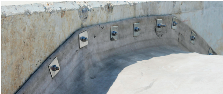
CC fijado a muro de cabecera de hormigón
